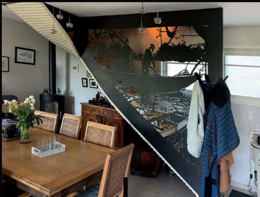
Cette structure en tôle d'acier est découpée au laser ; les marches en chêne massif sont protégées par deux couches de vernis avec une rampe personnalisée. Puis, une pièce est sublimée par une verrière et une porte coulissante vitrée en Dark Grès de caractère, travaillées en acier thermolaqué.
