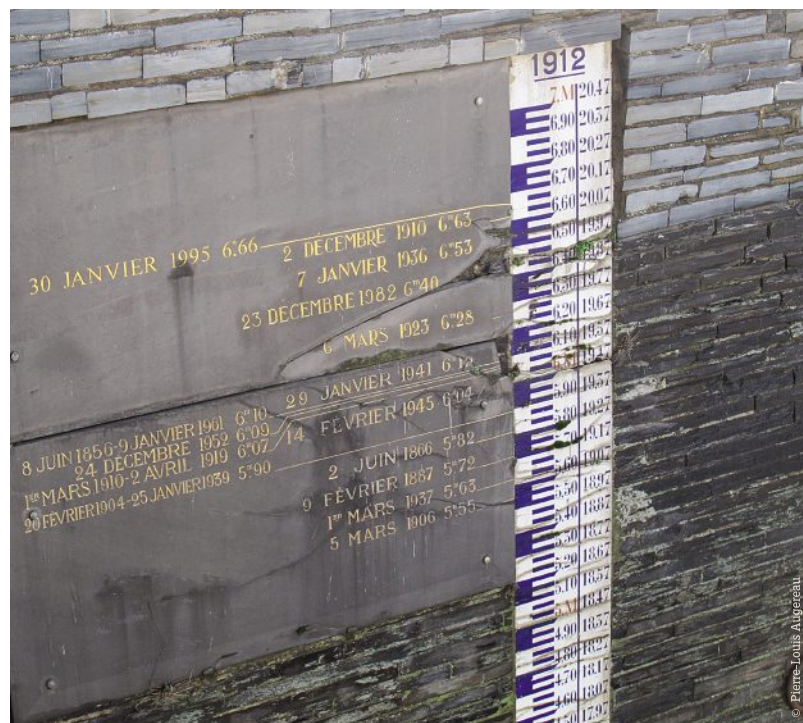
L'échelle des crues du pont de Verdun, prise ici en photo aux basses eaux, raconte les principales crues d'Angers
