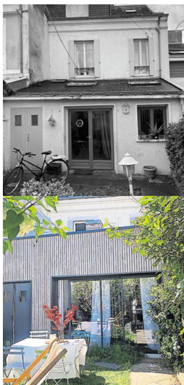
Avant/après : création d'une extension en ossature bois sur une maison
